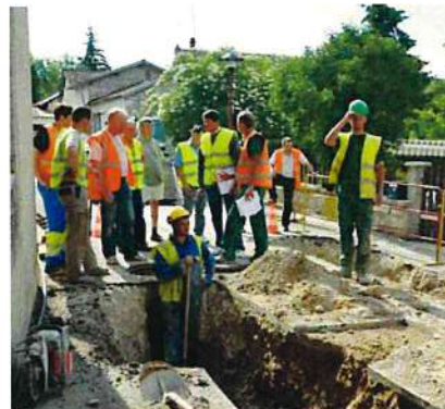
Réunion de chantier hebdomadaire
