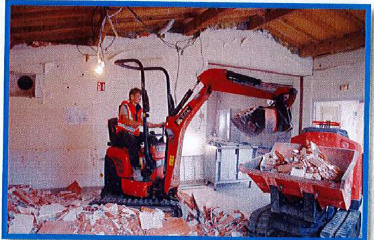
Travaux de la salle polyvalente
